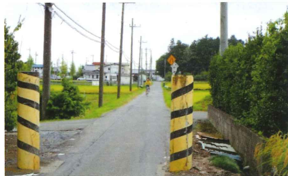
写真-39 車幅制限のある道路 2012(H24).09.28
