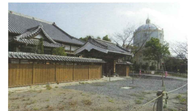
写真-6 東武館と水戸市低水配水塔 2012(H24).09.28
