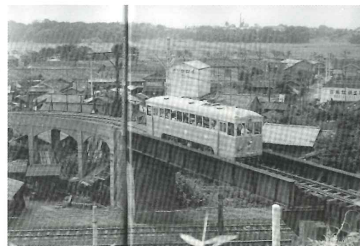
写真-19 常磐線跨線橋 1965(S40).07 出典3)
