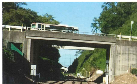
写真-16 現在は国道51号 2012(H24).09.28
