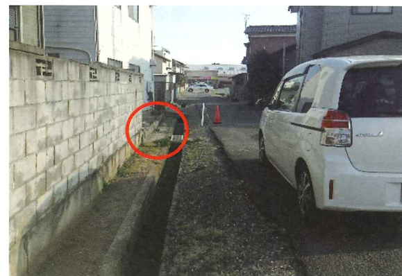
写真-59 手前の端に標柱 2015(H27).02.11
